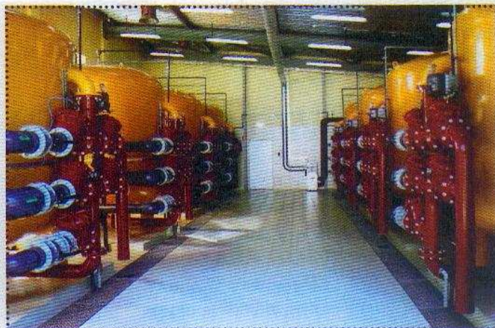
Fot. 4. Hala filtrów
