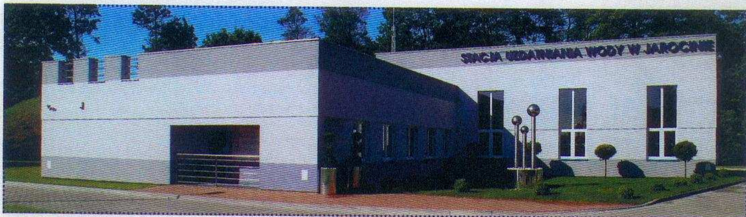
Fot. 2. Nowy budynek SUW
